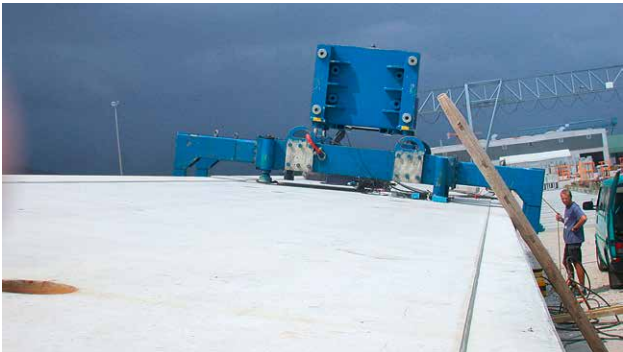
Befestigung des DYNAQ® auf einer Gleistragplatte
